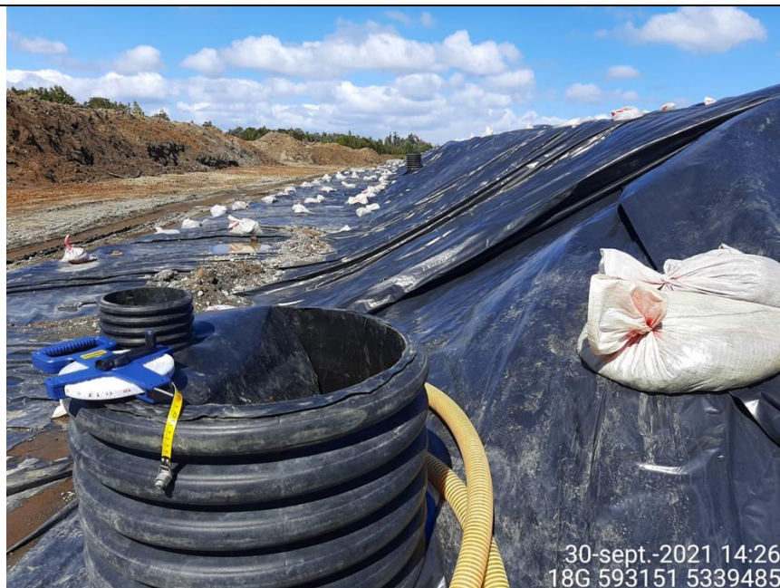
Fotografía N°18: Medición de Niveles de cámaras de inspección por Personal Municipal.
