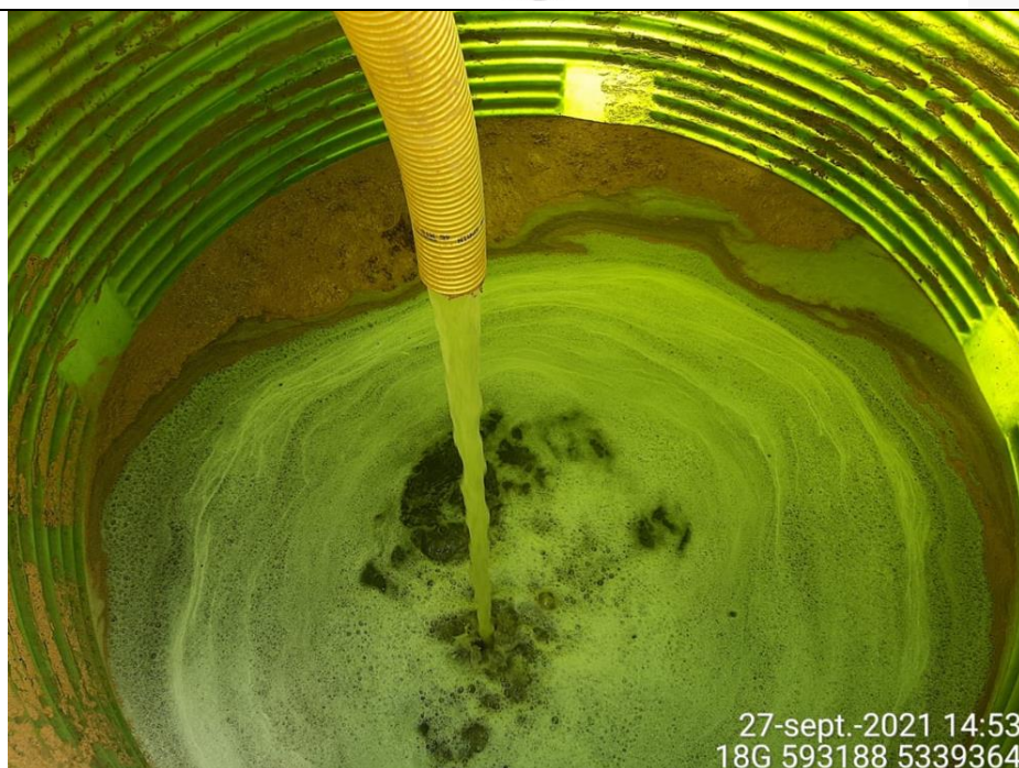
Fotografía N°2: Retiro de Lixiviados a estanque de acumulación por Personal Municipal. Tomada: Lunes 27 de Septiembre del 2021.
