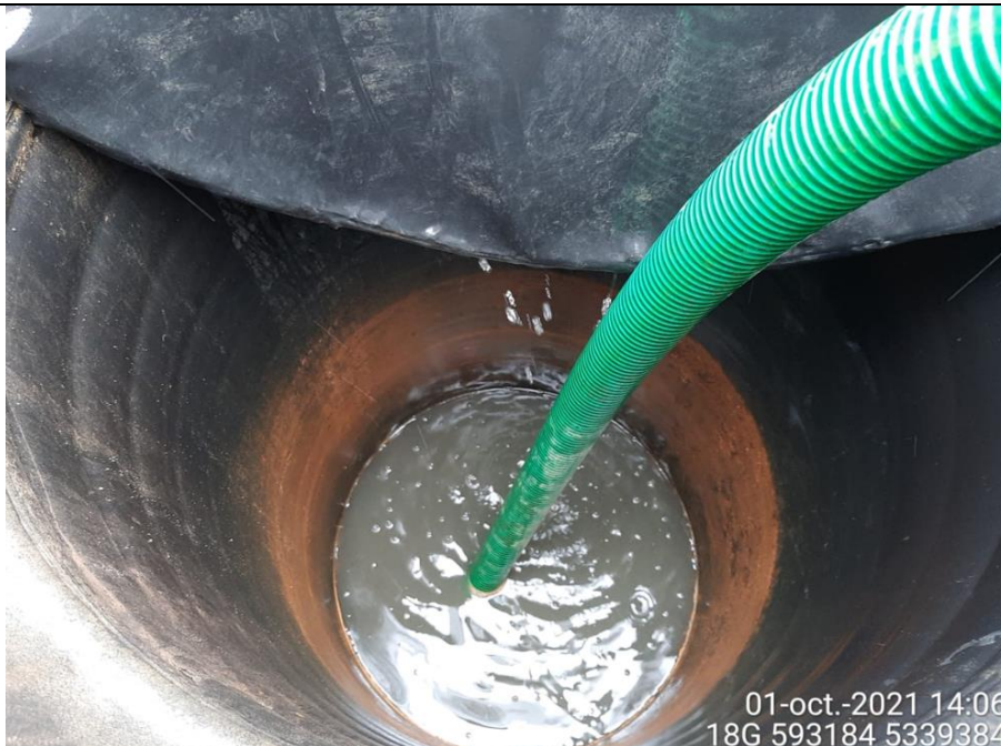
Fotografía N°9: Extracción de Lixiviados desde cámara de inspección sobrecelda. Tomada: Viernes 01 de Octubre del 2021
