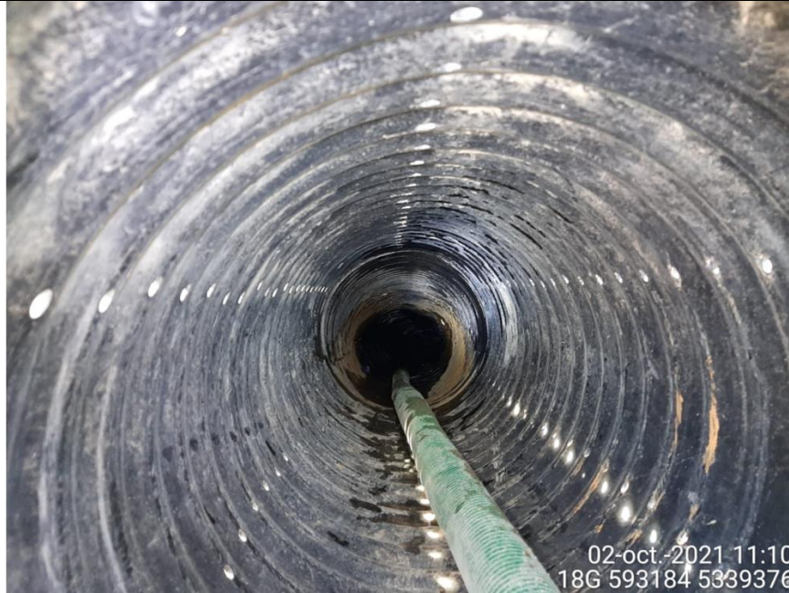
Fotografía N°11: Retiro de Lixiviados desde Ducto diagonal D2 por personal Municipal. Tomada: Sábado 02 de Octubre del 2021
