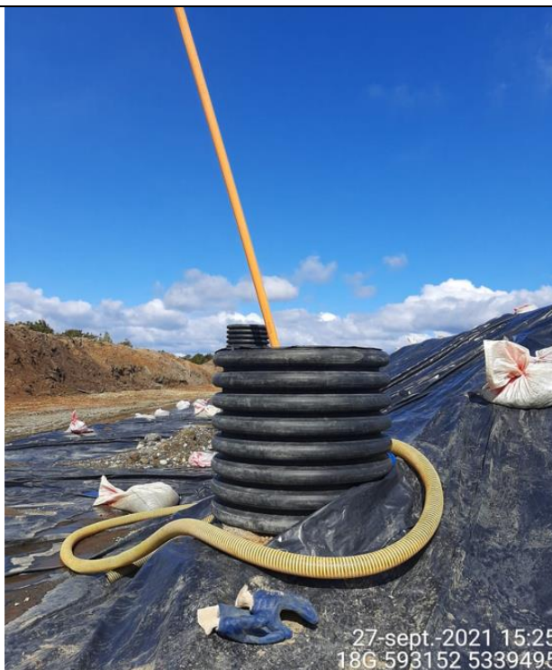
Fotografía N°15: Medición de Niveles de cámaras de inspección por Personal Municipal. Tomada: 27 de Septiembre del 2021.
