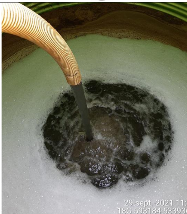
Fotografía N°6: Extracción de Lixiviados a estanque de acumulación. Tomada: Miércoles 29 de Septiembre del 2021
