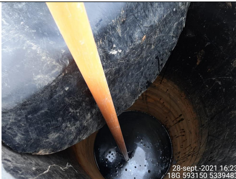
Fotografía N°16: Medición de Niveles de cámaras de inspección por Personal Municipal. Tomada: 28 de Septiembre del 2021.
